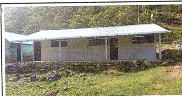
Foto 5: vista panoramica del establecimiento educativo despues de la culminacion del trabajo de remozamiento
