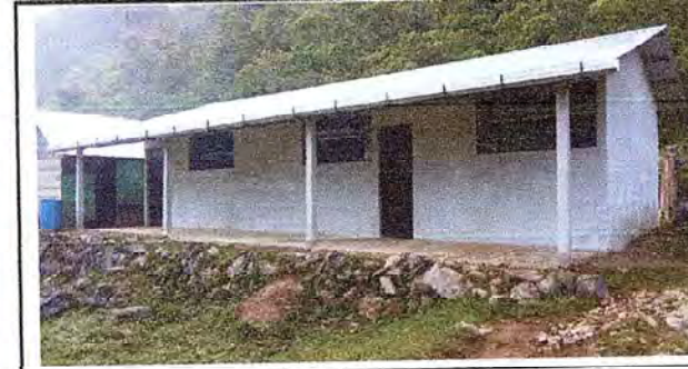
Foto 6: Observandose los diferentes procesos realizados en la remodelación del establecimiento educativo instalación de techo, puertas, ventanas, piso y canal.
