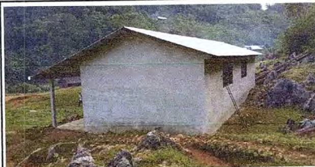
Foto 2: vista Frontal, donde se observa la colocación de costaneras y láminas troqueladas del establecimiento educativo.
