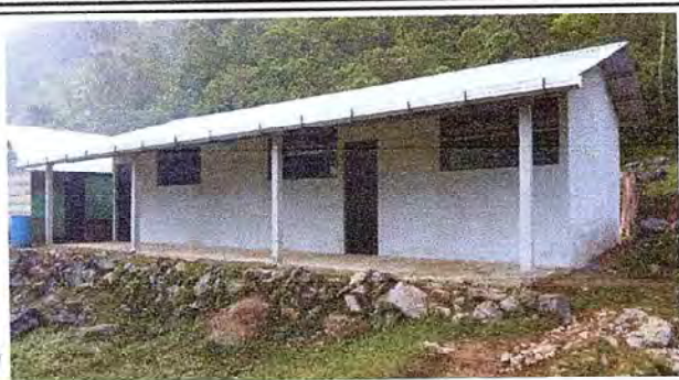
Foto 1: Luego de haber realizado los diferentes procesos de remodelación del establecimiento educativo.
